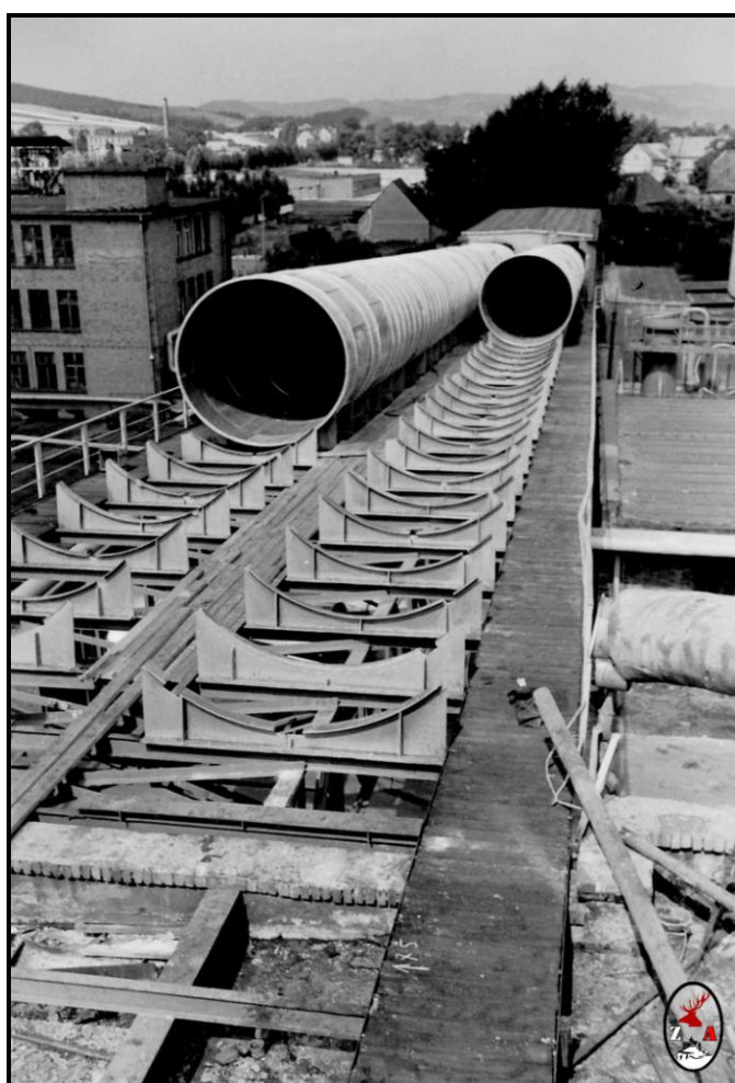
Dla polepszenia wentylacji dachy włóknieni podniesiono o 1,5 metra.
