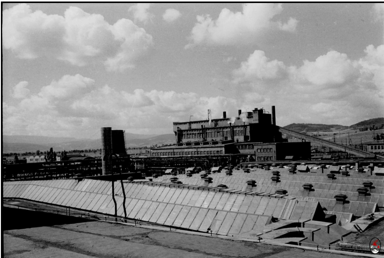
Dla polepszenia wentylacji dachy włóknieni podniesiono o 1,5 metra.
